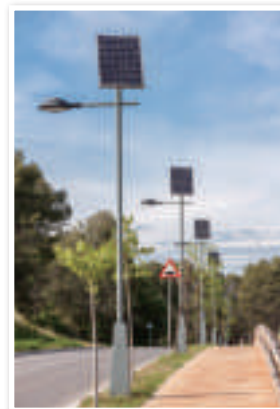
▶ 圖 1-9 太陽能發電路燈能於白天發電並儲存能量，供晚上照明使用。
