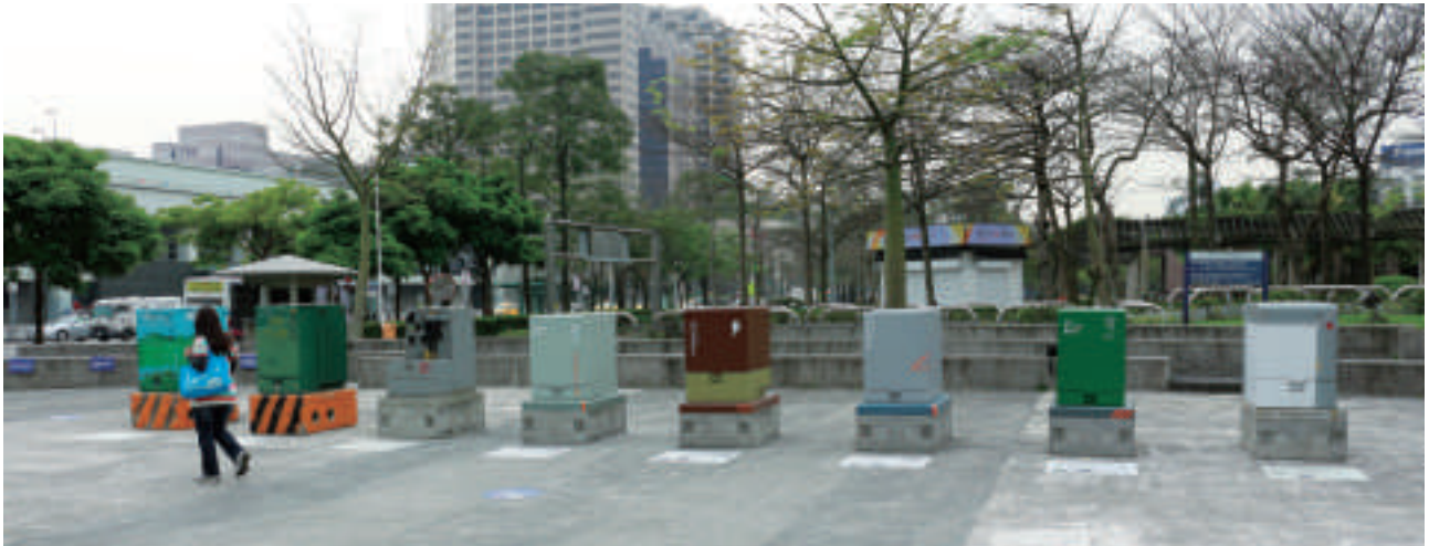
►圖30 在變電箱漆白的同時，於臺北市政府前廣場展示不同區域的色彩觀察以及變電箱設計款式。
