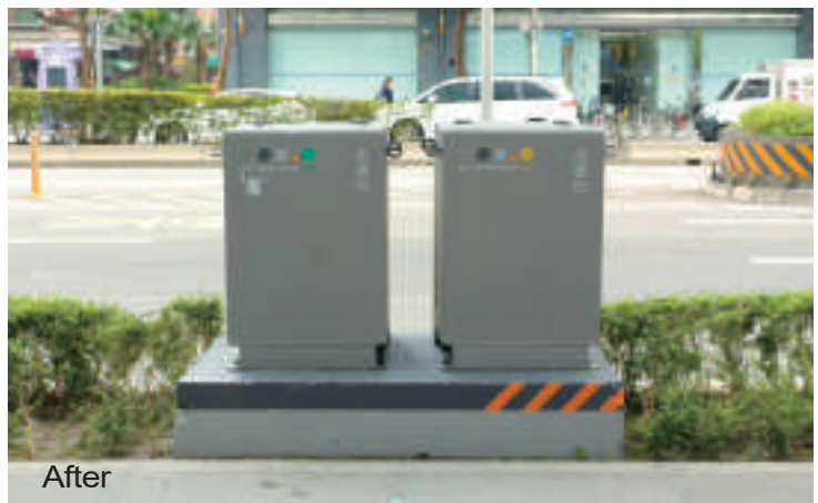
►圖31-32 原本的變電箱和經過減法設計的變電箱，改造包含：降低彩度、規畫符號標誌、局部凸顯警示色彩等，並在視覺上與周圍環境相調和。
