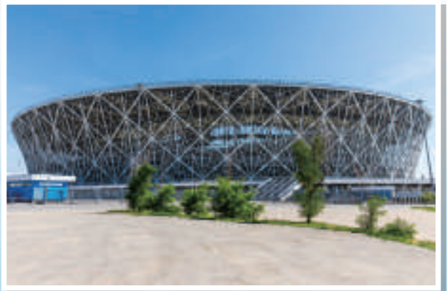
▲ 圖 4-9 桁架結構已廣泛使用於體育館等大型建築。
