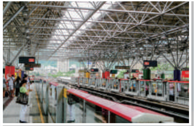
▲ 圖 4-8 許多車站的屋頂以桁架為主要結構（圖為捷運北投站）。
