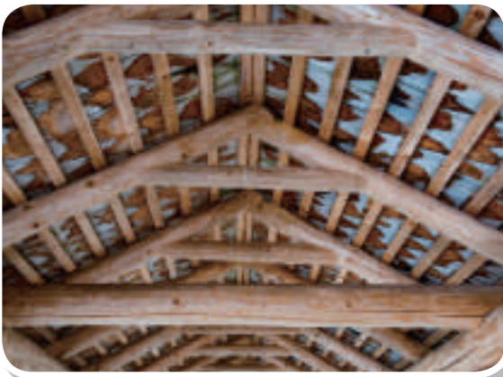
▲圖 4-13 木造屋頂的桁架為主要的承重結構。
