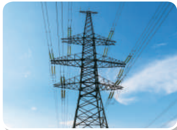
▲圖 4-14 高壓電塔以桁架結構建造而成。
