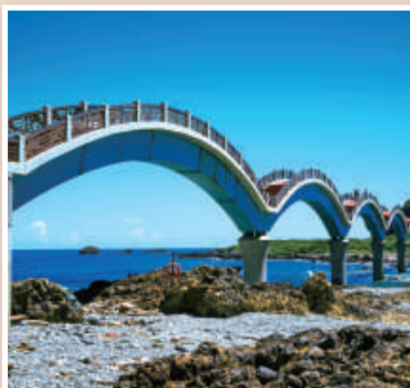
臺灣臺東縣三仙台跨海拱橋。
