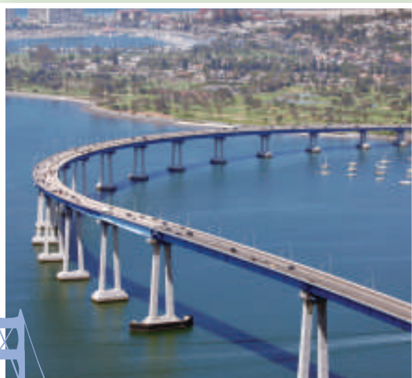
美國聖地牙哥科羅拉多大橋 （Coronado Bridge）。
