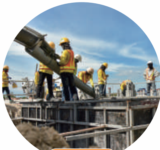
現場施工人員
