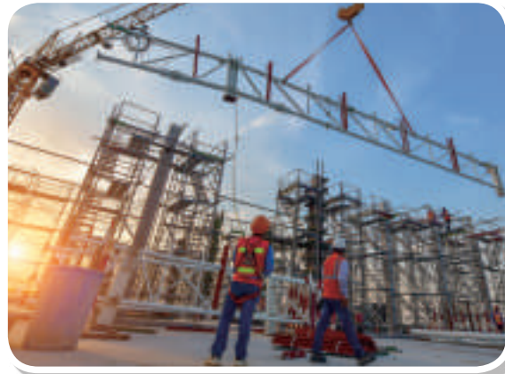
▲圖 4-12 建築工地中常可見到桁架的應用。
