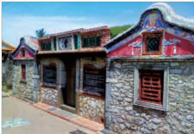
▲圖 6-12 咕硿石為露出海面的珊瑚礁， 澎湖 居民就地取材拿來建造房屋。
