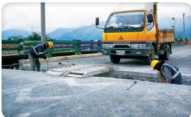
△圖1-3-17 橋面整平工程／受板塊運動影響，玉里大橋橋面會出現高低起伏的情況，施工人員正進行橋面的保養與維修工程。
